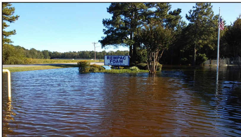
REMPAC Foam Site Flooding
